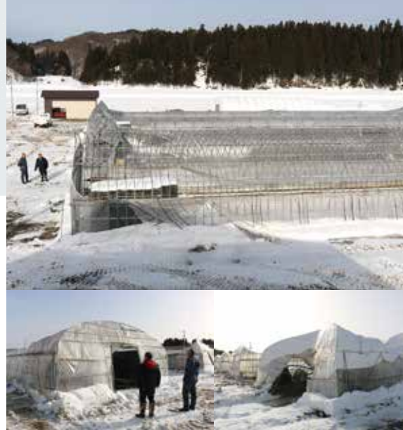
▲暴風雪によって倒壊したハウス(秋田市河辺)
